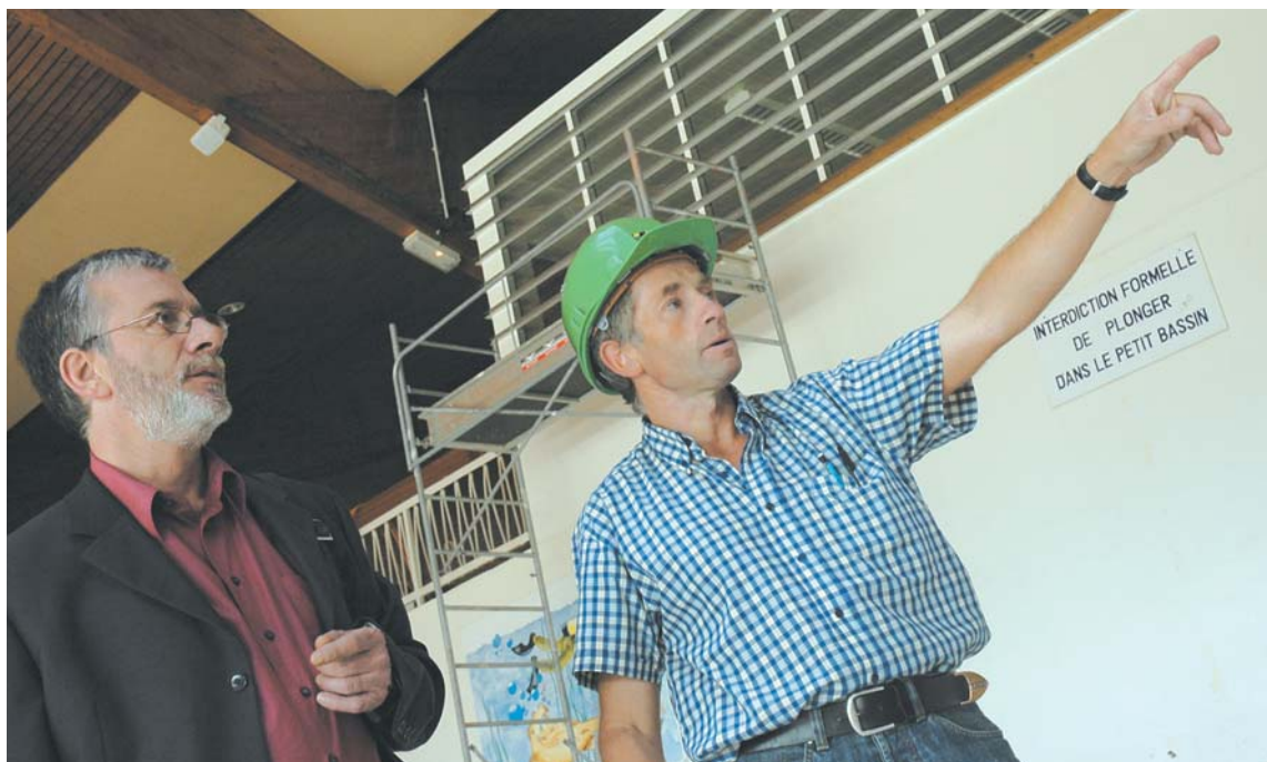
Michel Rodriguez, maire adjoint et Hervé Réaux, responsable du service des sports, en visite sur le chantier.
