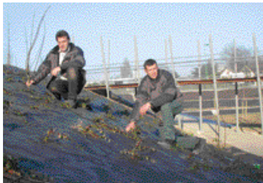
Le gros des aménagements est aujourd'hui terminé. Les plantations vont se poursuivre tout le printemps.
