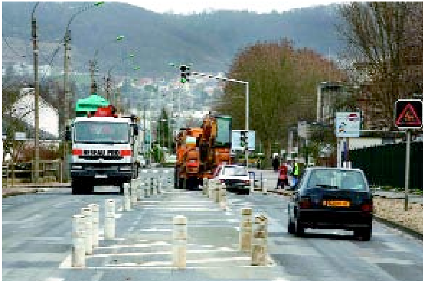
L'enfouissement des réseaux électriques et téléphoniques va démarrer courant avril.
