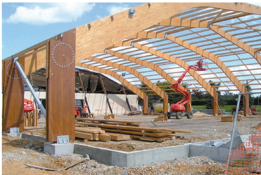
L'ossature bois du bâtiment donne une idée de son ampleur future.
