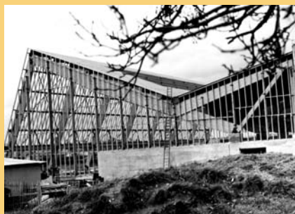
La construction de la piscine, inaugurée en 1971.
