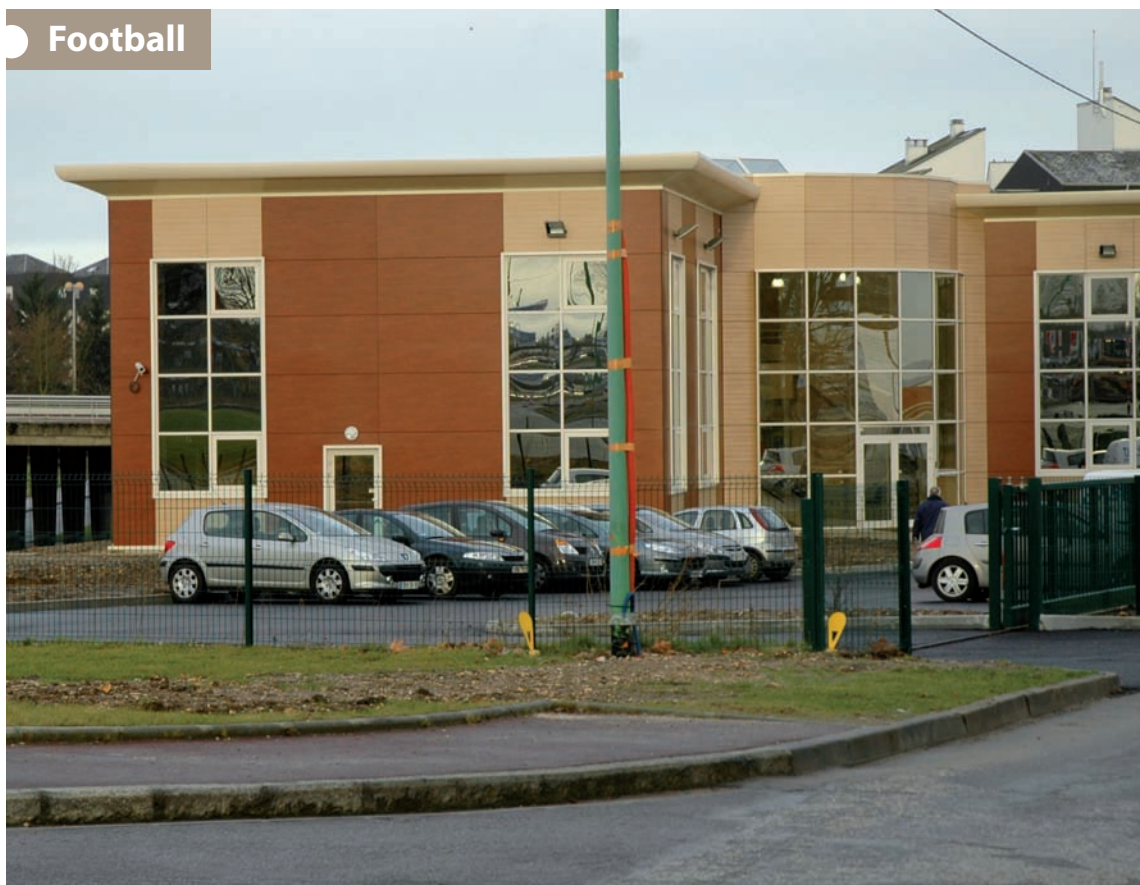
Les nouveaux locaux de la Ligue, avenue Felling.
