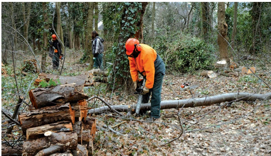
Le bois est débarrassé de ses branches menaçantes afin d'en sécuriser l'accès.
