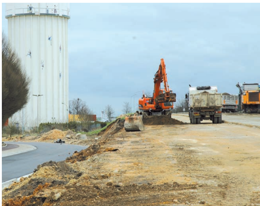
A gauche la nouvelle avenue de Felling. A côté, l'ancienne voie en cours de résorption.
