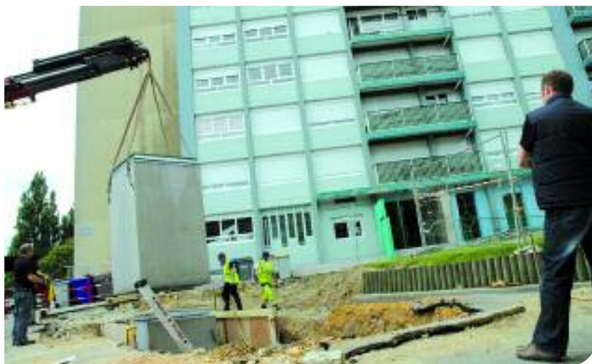
Six tonnes au bout du bras : les silos dans leurs blocs de béton ont été installés en juin.
