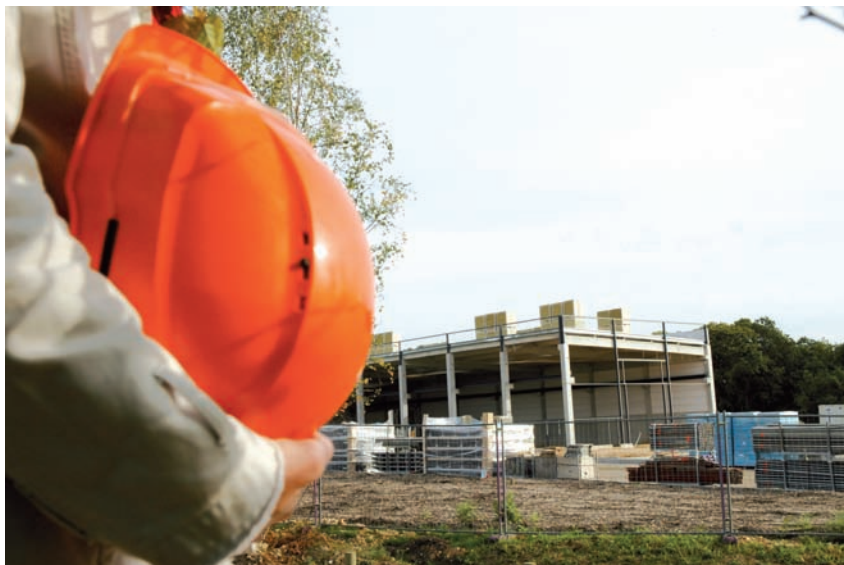
Le nouveau siège social de Normandie manutention en pleine construction.
