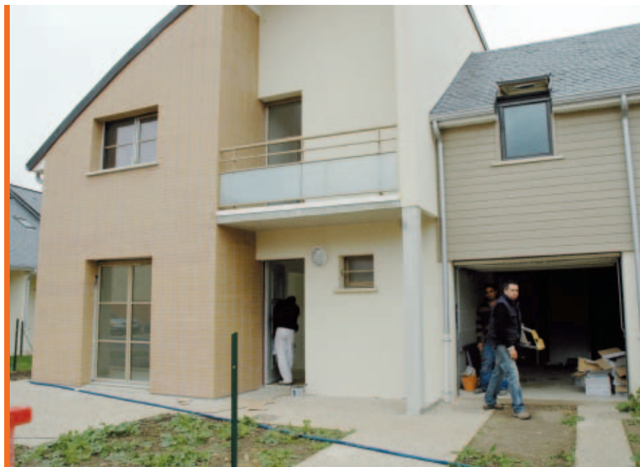
Des pavillons de qualité, en cours de finition, en bordure de la rue Ernest-Renan.
