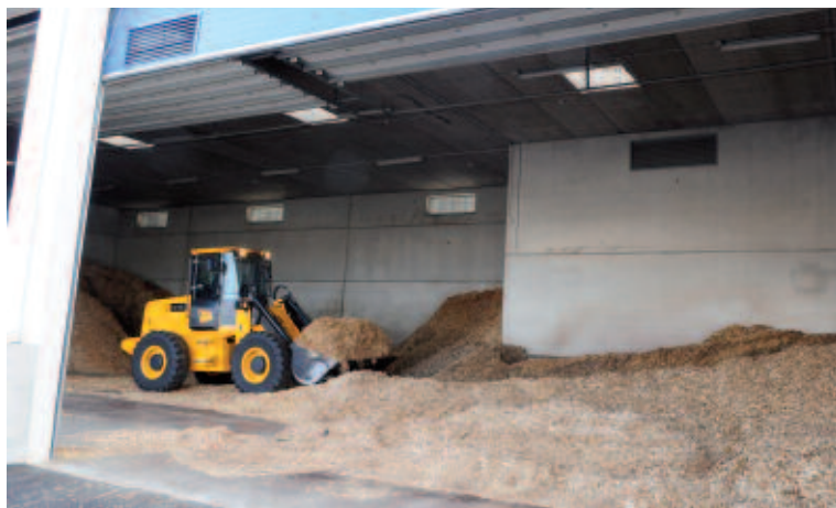
Les miettes de bois sont poussées par une pelleteuse puis mécaniquement vers les chaudières.
