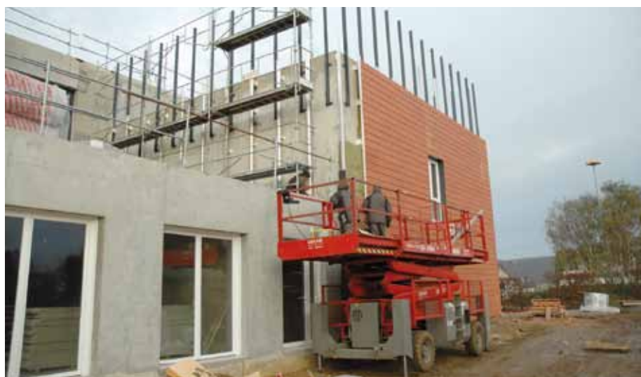
L'Éhpad, en construction rue Félix-Faure, sera terminé d'ici l'été 2011.
