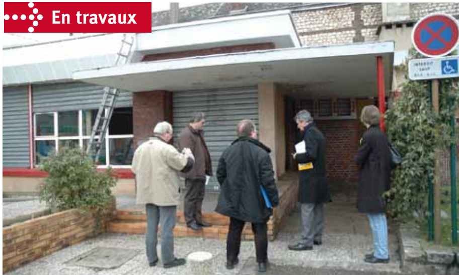
Visite des services techniques, pour préparer le chantier place Louis-Buée.
