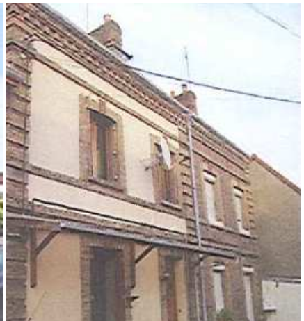
Maison en briques et moellons partiel
