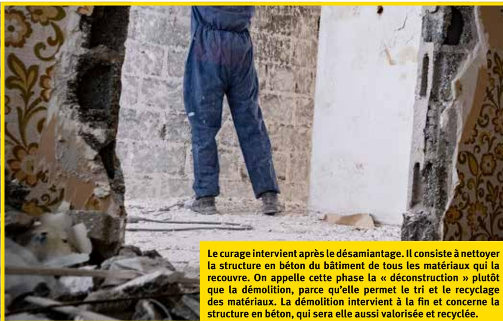
Le curage intervient après le désamiantage. Il consiste à nettoyer la structure en béton du bâtiment de tous les matériaux qui la recouvre. On appelle cette phase la « déconstruction » plutôt que la démolition, parce qu'elle permet le tri et le recyclage des matériaux. La démolition intervient à la fin et concerne la structure en béton, qui sera elle aussi valorisée et recyclée.
