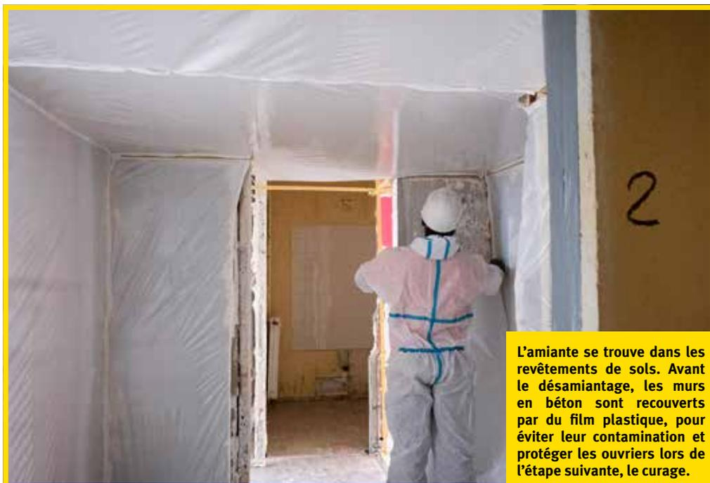
L'amiante se trouve dans les revêtements de sols. Avant le désamiantage, les murs en béton sont recouverts par du film plastique, pour éviter leur contamination et protéger les ouvriers lors de l'étape suivante, le curage.
