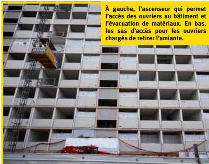
À gauche, l'ascenseur qui permet l'accès des ouvriers au bâtiment et l'évacuation de matériaux. En bas, les sas d'accès pour les ouvriers chargés de retirer l'amiante.
