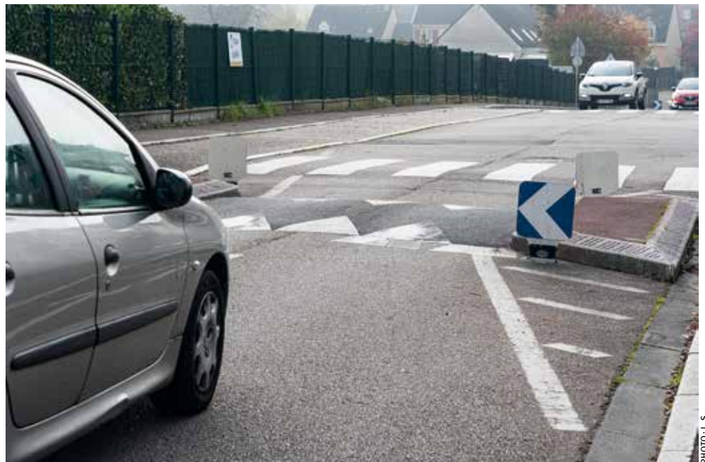
▲ Deux types d'aménagements de voirie pour réduire la vitesse : un ralentisseur écluse rue Danielle-Casanova (ci-dessus) et un plateau surélevé avenue du Val-l'Abbé.
