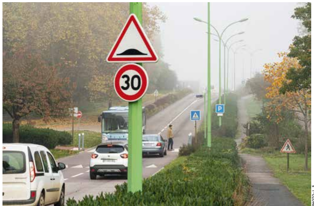
▲ Deux types d'aménagements de voirie pour réduire la vitesse : un ralentisseur écluse rue Danielle-Casanova (ci-dessus) et un plateau surélevé avenue du Val-l'Abbé.
